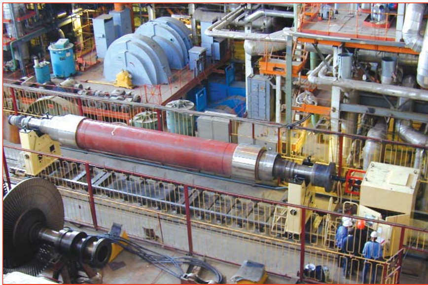
Рис. 2. Балансировочный станок VM-90000 во время балансировки ротора генератора на электростанции
